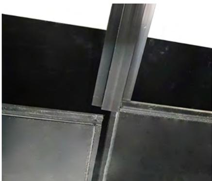
Con un perfil de conexión de aluminio se encajan entre sí los extremos de las paredes del tubo
