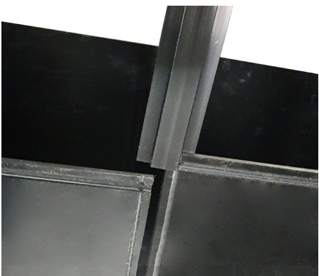
Met een aluminium verbindingsprofiel worden de uiteinden van de buiswanden in elkaar geklikt.
